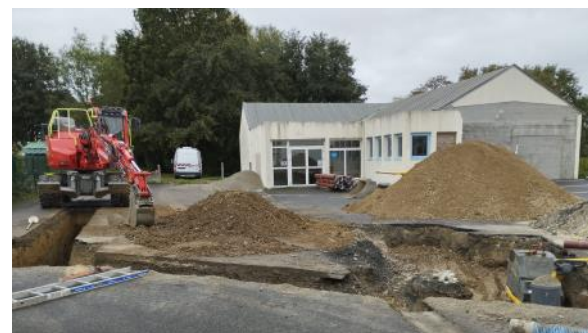
Travaux réalisés en octobre - dévoiement du réseau d'assainissement traversant le Pôle Asso.
