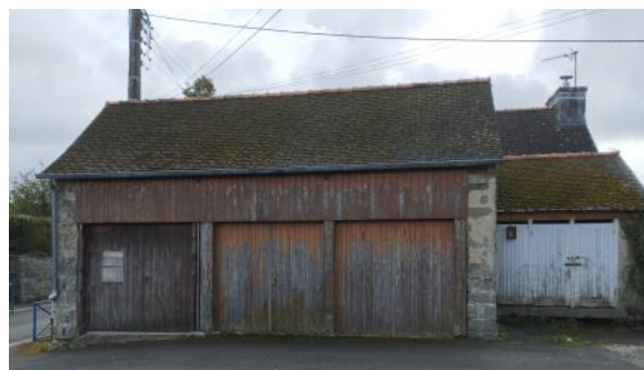
Bâtiments annexes du Pôle Associatif : démolition programmée sur novembre.
